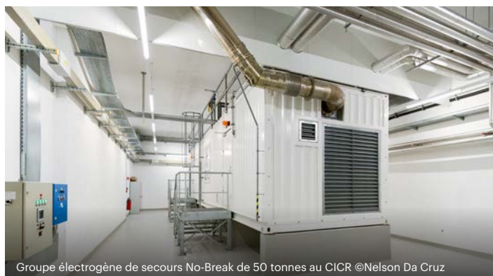
Groupe électrogène de secours No-Break de 50 tonnes au CICR ©Nelson Da Cruz
